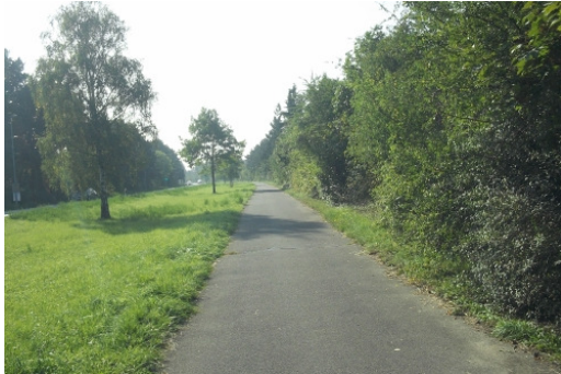
Radweg auf Westseite Westring zwischen Hessheimer Straße und Lamsheimer Straße 100_1019_klein.jpg
